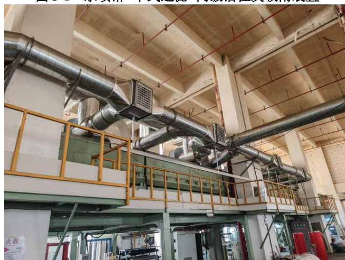
图 3-1 水喷淋+干式过滤+两级活性炭吸附装置
