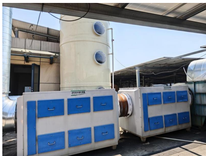
图 3-1 水喷淋+干式过滤+两级活性炭吸附装置
