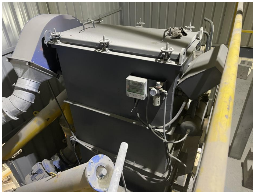
图 3-2 增强型覆膜滤料材质布袋除尘器
