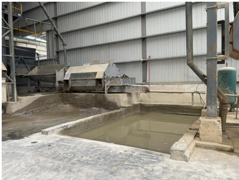
图 3-4 室内堆场蓄水池
