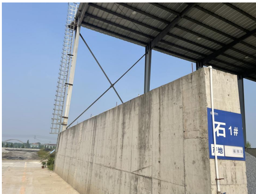
图 3-3 卸料堆场除雾喷头
