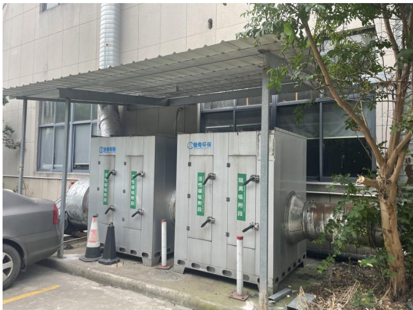
图 3-3 表面处理废气处理装置
