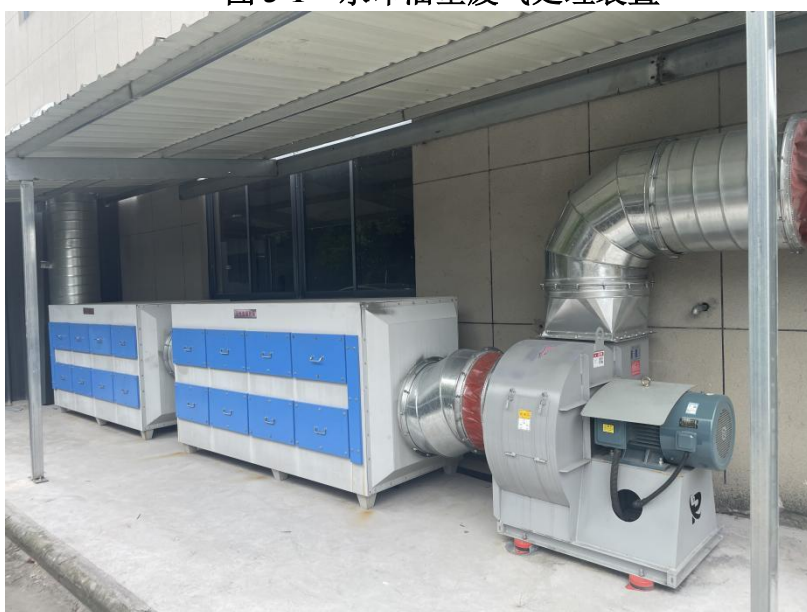
图 3-2 胶印油墨废气处理装置
