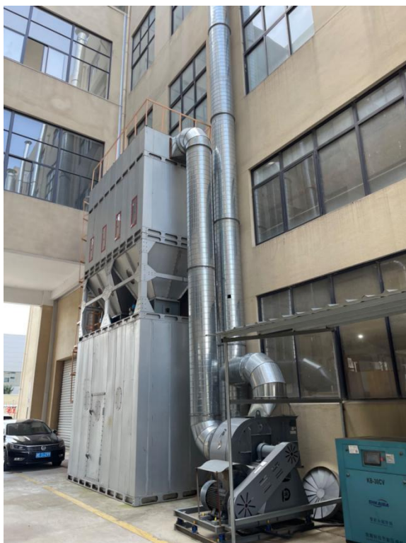
图 3-1 脉冲布袋除尘器
