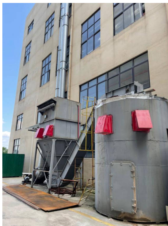
图 3-1 脉冲布袋除尘器
